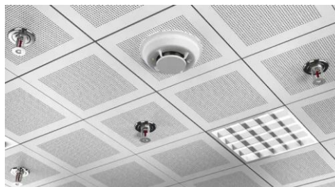
รูปภาพที่ 3.24 Smoke Detector
