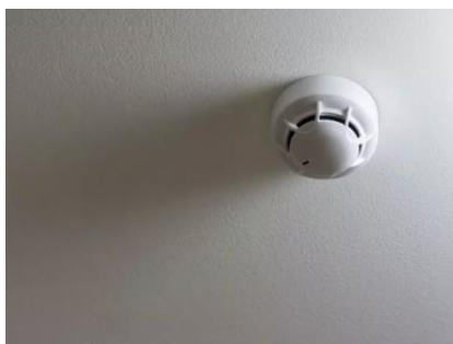
รูปภาพที่ 3.25 Heat Detector
