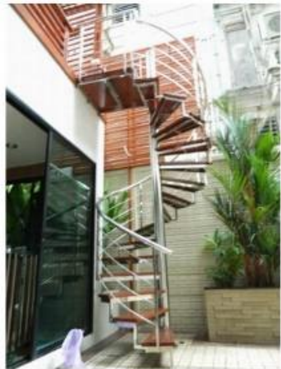
บ้านโตเวียน โครงเหล็ก ชั้นบันไดไม้
