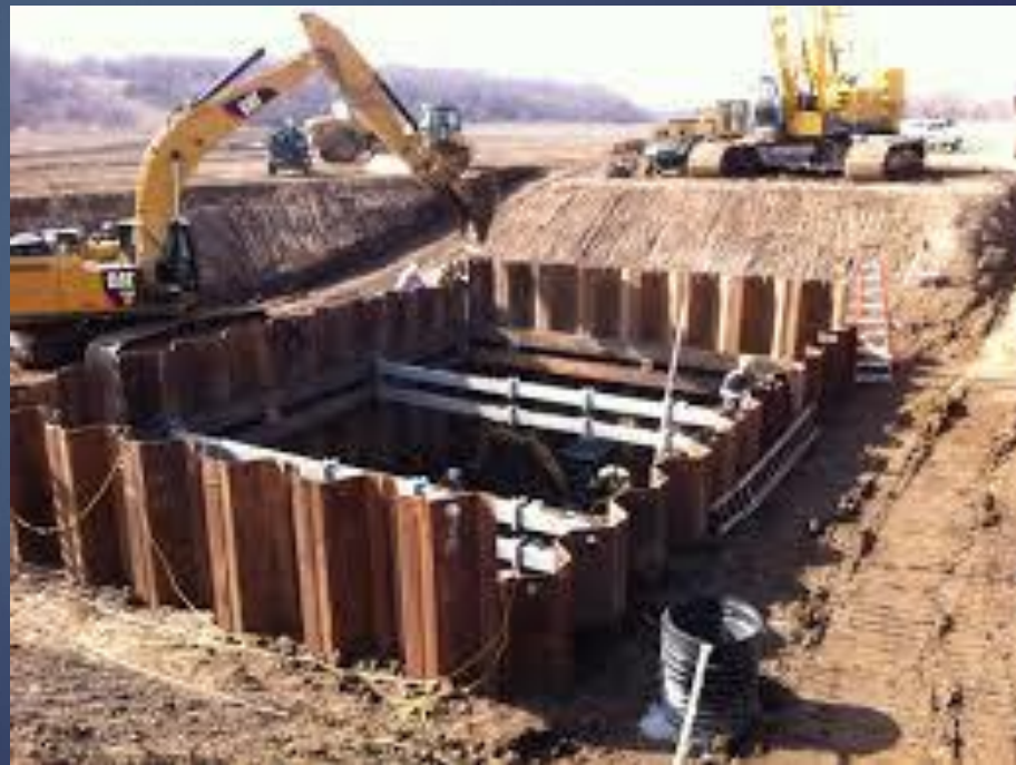
SHEET PILE เข็มพีด
